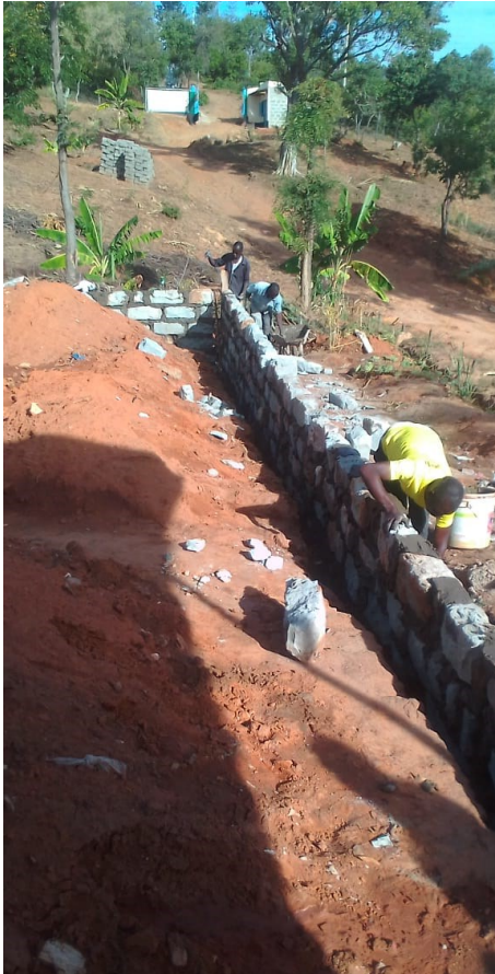
ii Het werk aan de school kapel is al begonnen!
